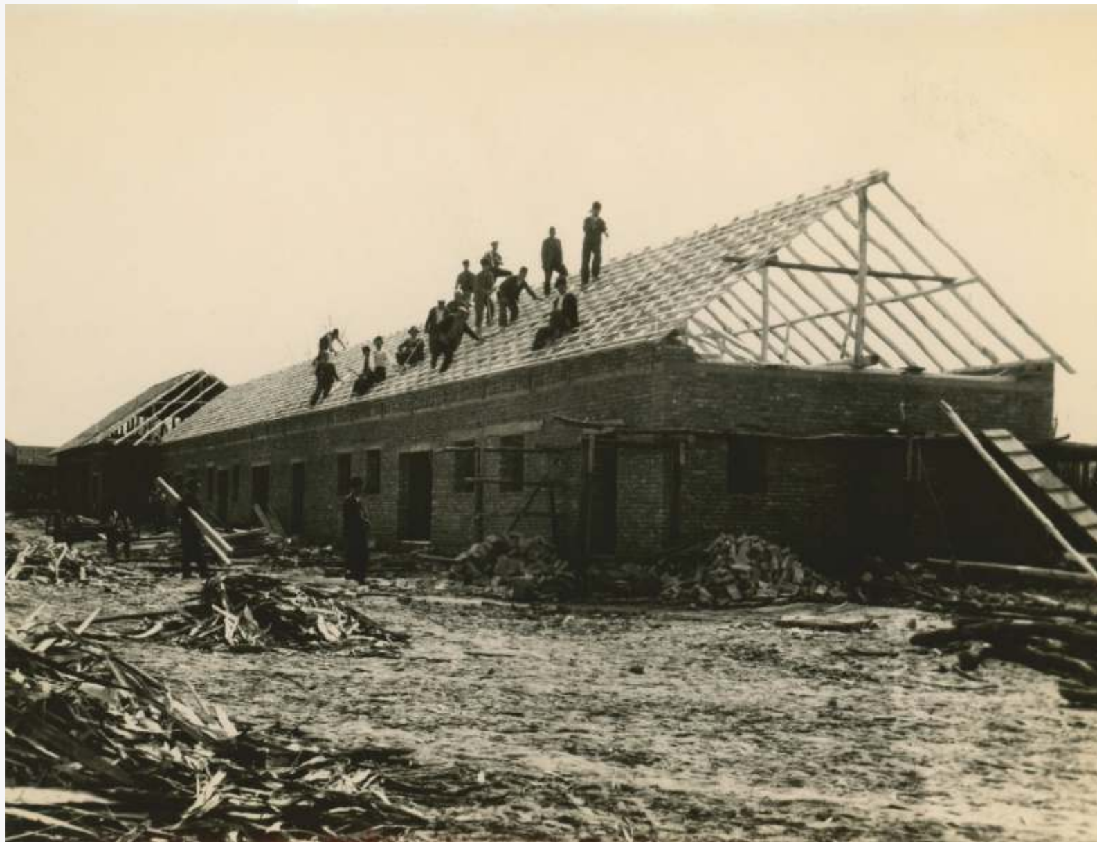
Piscu Vechi - Construcție magazie CAP
