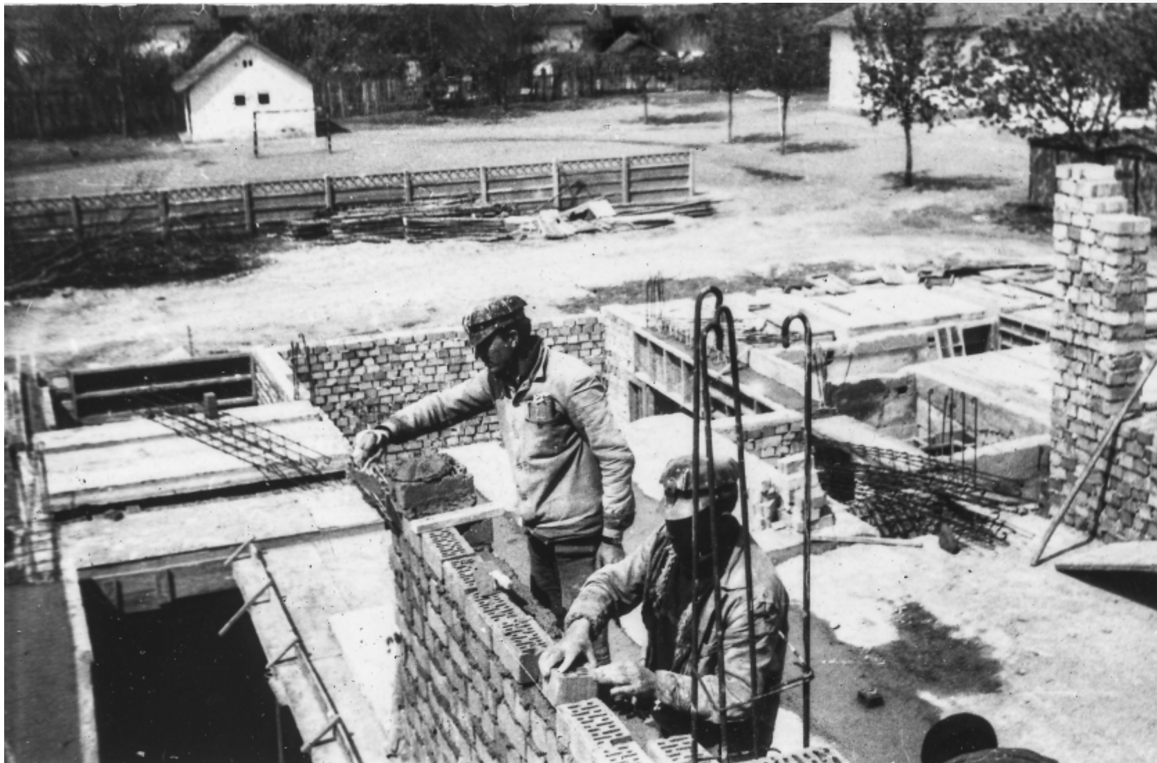
Băilești - Se construiește primul bloc pe strada 30 Decembrie
