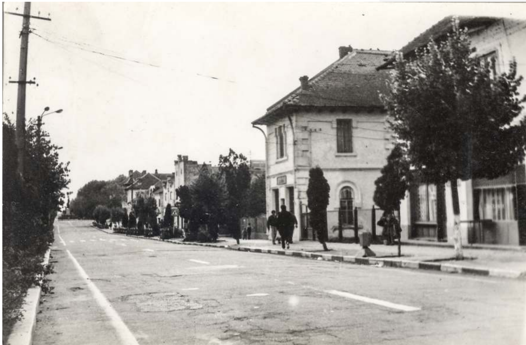
Băilești - Strada Mare
