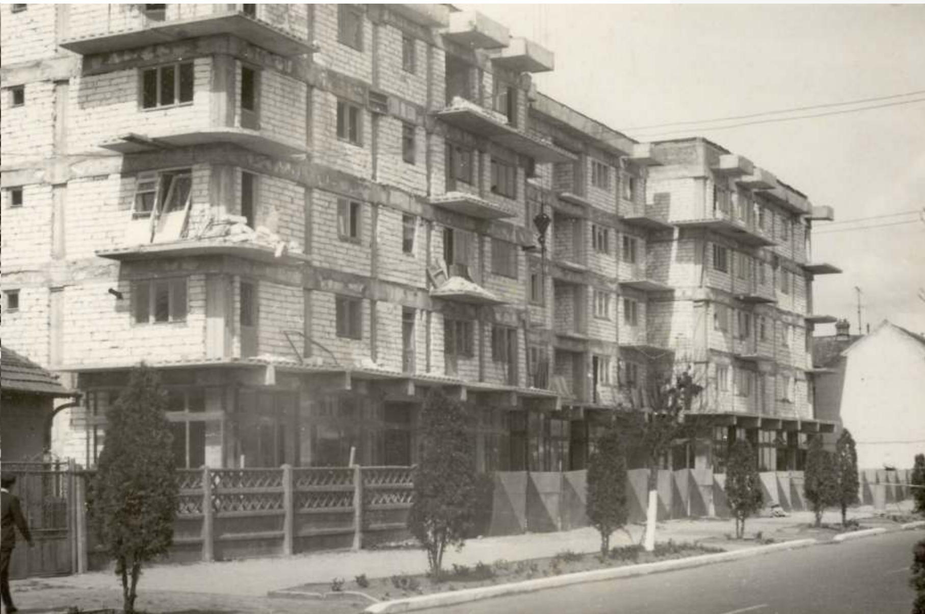
Băilești - Construcție blocuri noi
