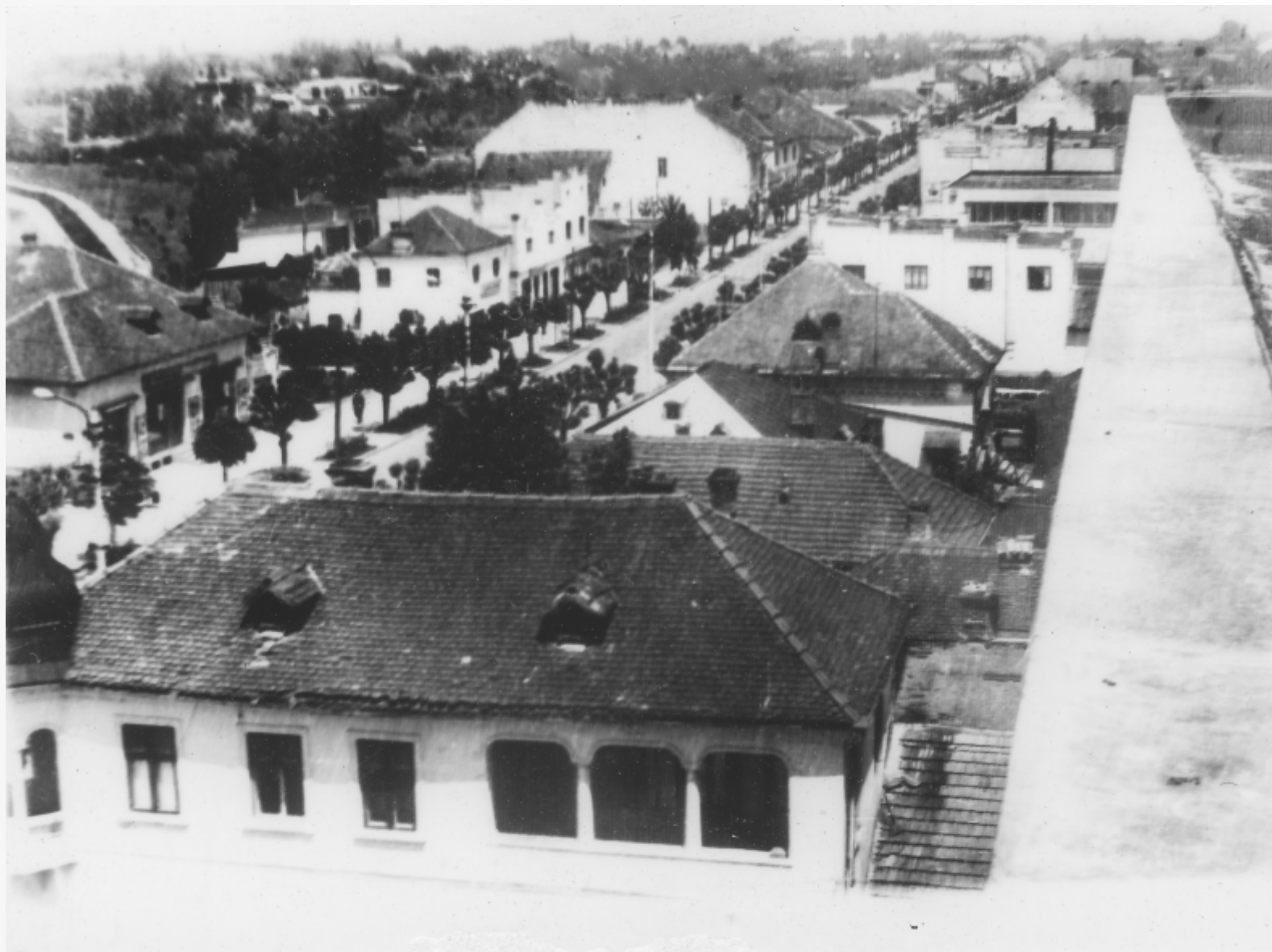
Băilești - Strada Mare
