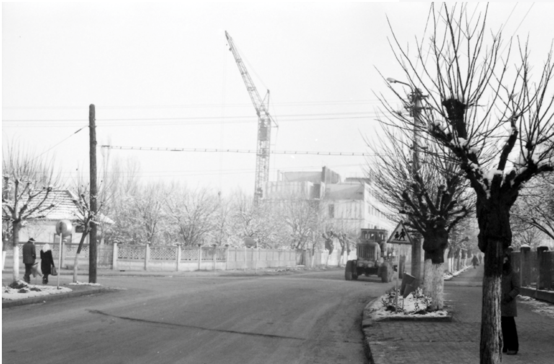
Băilești - Construcția căminului de nefamiliști
