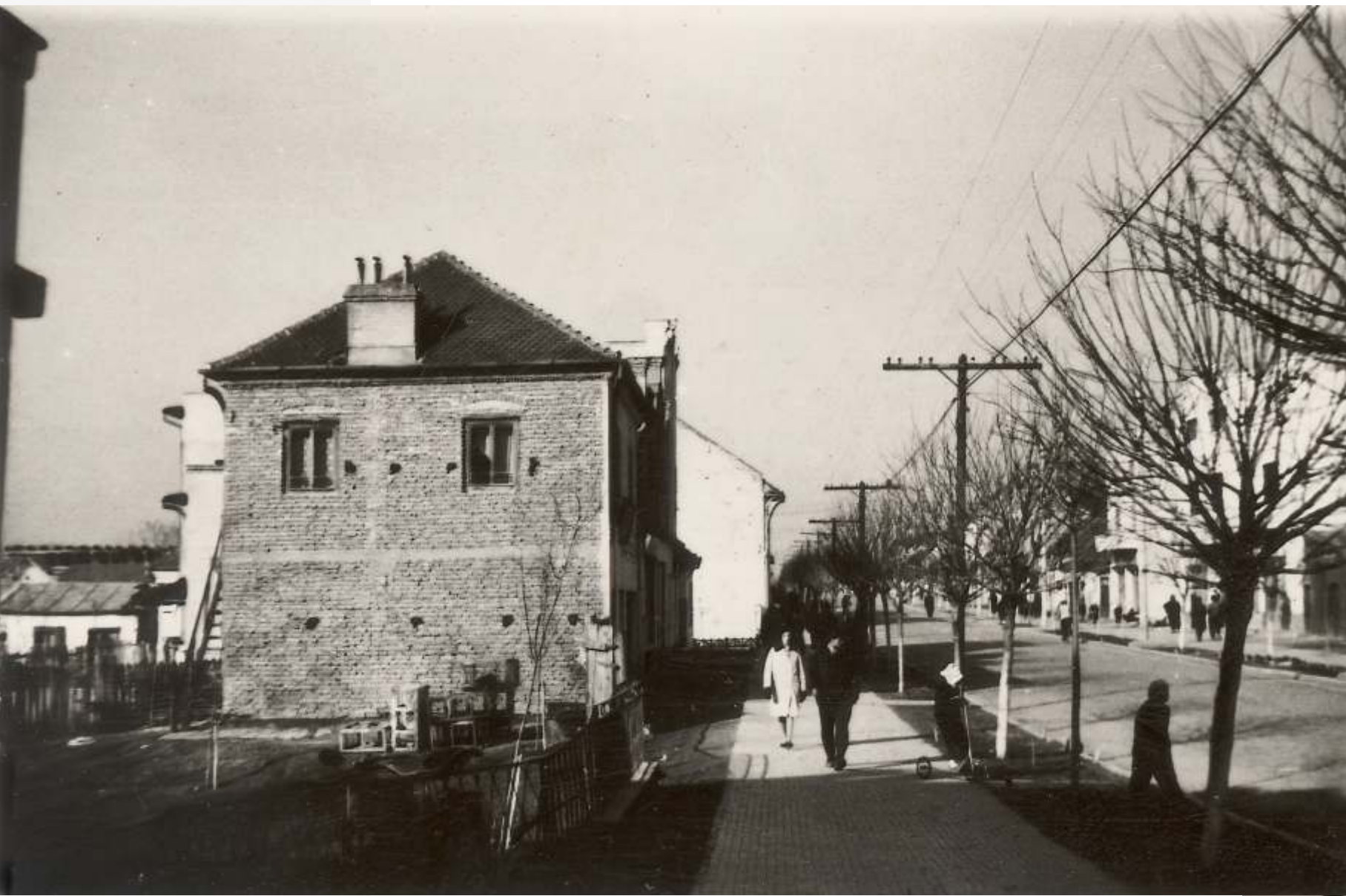
Băilești - Strada Mare
